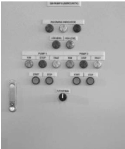
Hình 3.8. Lắp đặt hệ thống tủ điện
