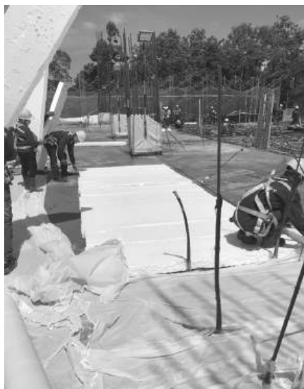
Hình 3.11. Che phủ bề mặt bằng lớp xốp cách nhiệt
