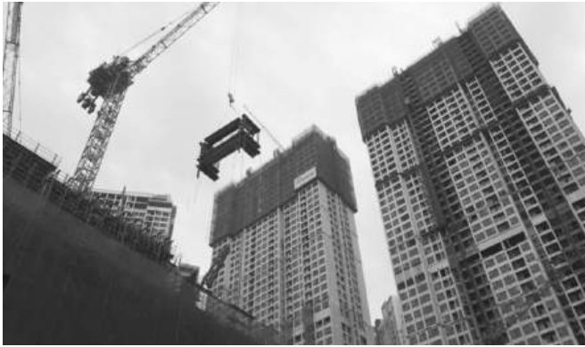
a. Hệ thống ván khuôn leo được vận hành bằng cầu tháp
