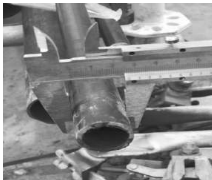
Hình 3.1. Kiểm tra đường kính ống thép
