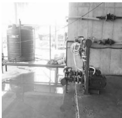
Hình 3.9. Thử áp hệ thống
