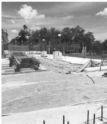
Hình 3.12. Che phủ bề mặt bằng 3 lớp vật liệu cách nhiệt
