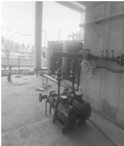
Hình 3.7. Lắp đặt hệ thống bơm điện
