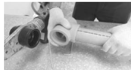
Hình 3.4. Thi công hàn ống nhiệt PPR
