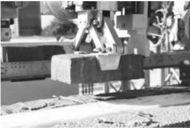
Robot xây dựng công trình
