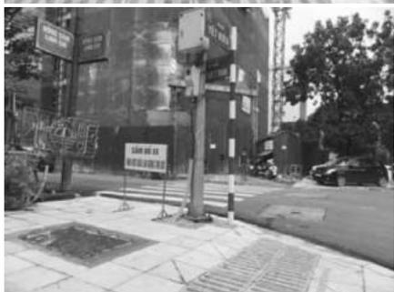
*Phần tấm lát dẫn hướng đường lề phải đặt dọc nhưng đơn vị thi công lại đặt ngang. Một số đoạn đường vẫn chưa được xây dựng khớp với nhau*
