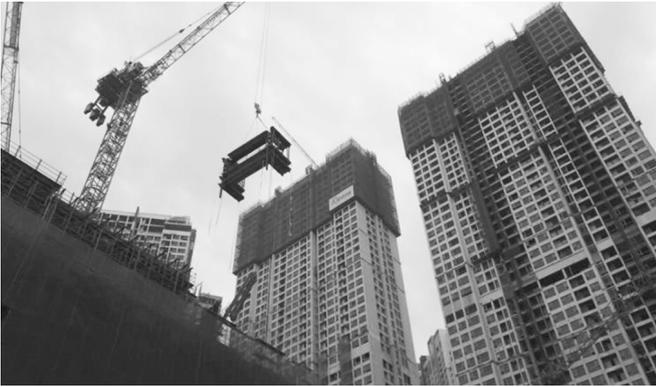
a. Hệ thống ván khuôn leo được vận hành bằng cầu tháp
