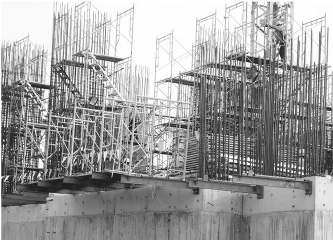
Hình 1-2: Một số cấu tạo liên kết hệ dầm I để đỡ hệ giáo ngoài
