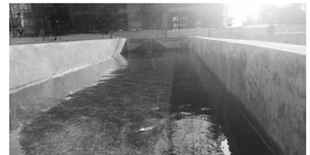
**Hình 3.10.** Bể hồi và cấp nước làm mát
