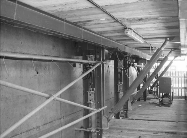
b. Hệ thống ván khuôn leo tự động bằng hệ thống kích thủy lực
