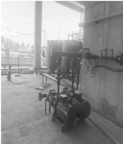
**Hình 3.7.** Lắp đặt hệ thống bơm điện
