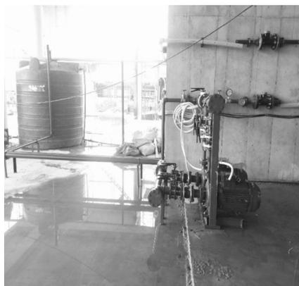
**Hình 3.9.** Thử áp hệ thống
