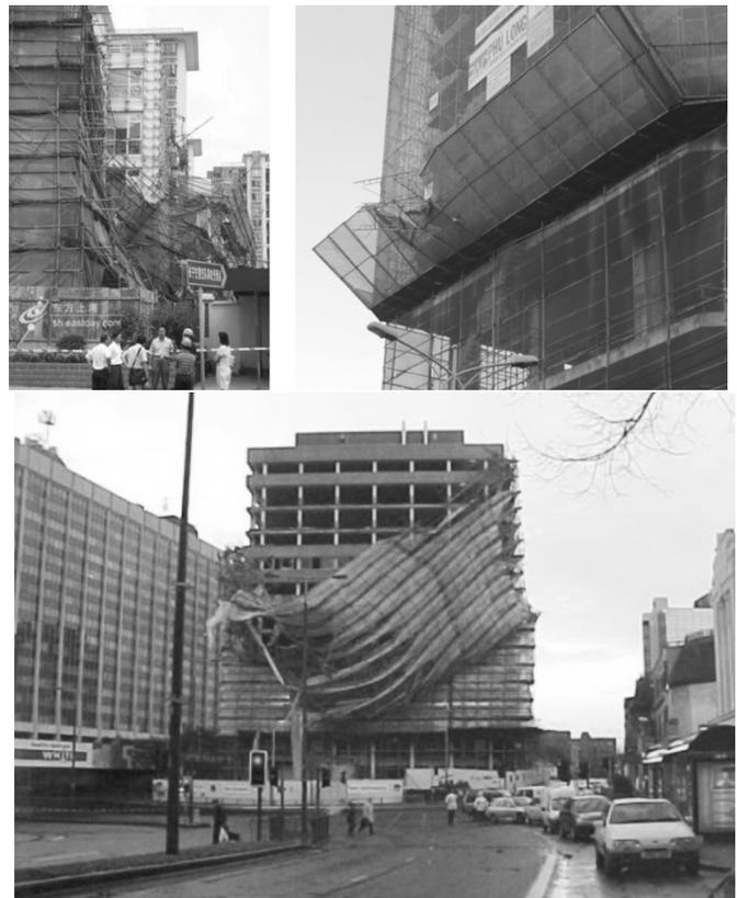
**Hình 1-1:** Một số sự cố mất an toàn đối với hệ giáo ngoài
