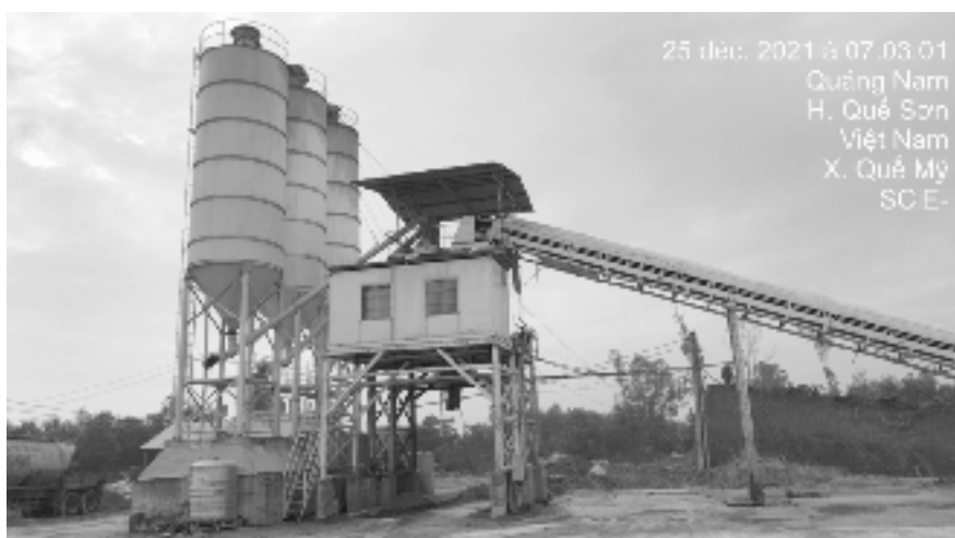
Hình 2. Hình ảnh xi lô chứa xi măng, phòng điều khiển và băng chuyền vận chuyển vật liệu tại một trạm trộn bê tông thương phẩm trên địa bàn tỉnh Quảng Nam.
