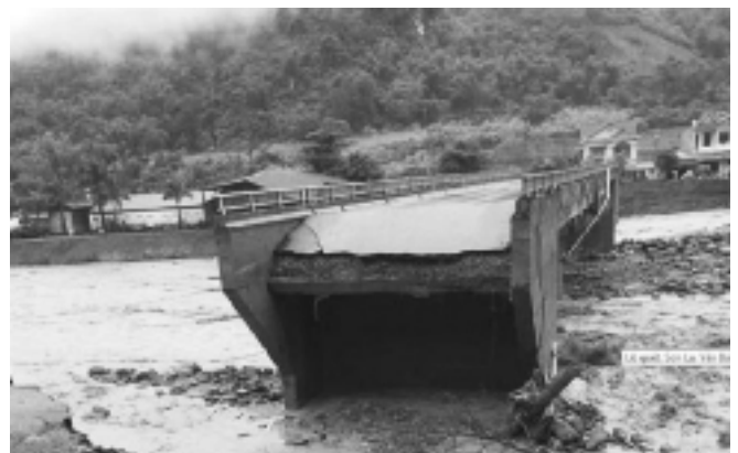
Hình 2. Sự cố hai đường đầu cầu Nậm Pấm bị lũ cuốn trôi
