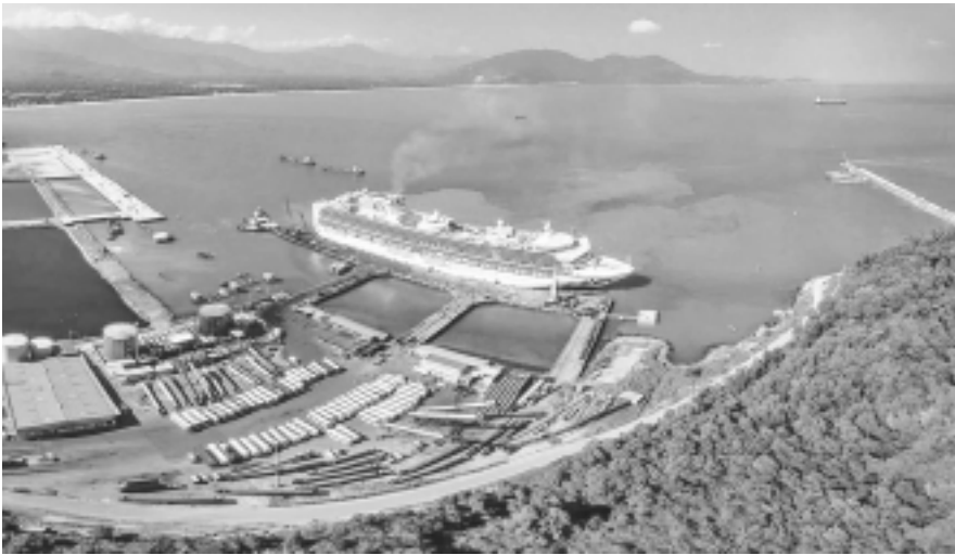
Khu Cảng biển nước sâu Chân Mây – Lăng Cô - Tỉnh Thừa Thiên - Huế
