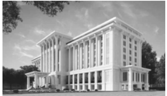
Hình 2. Dự án công trình trụ sở làm việc của Chính phủ và Văn phòng Chính phủ.
