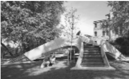
Cầu Striatum không sử dụng cốt thép hay vữa. Ảnh: ETH Zurich
